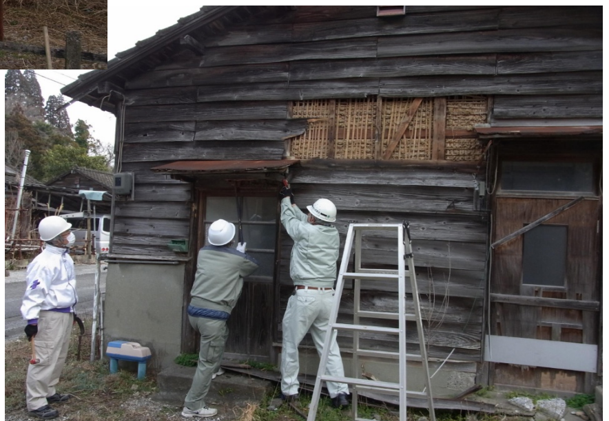
屋根瓦、外壁、庇の解体作業
