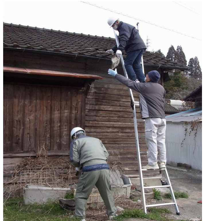
屋根瓦、外壁、庇の解体作業
