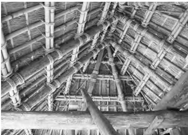
形は寄せ棟で東面屋根を地面まで葺き下ろし、精米室の作業や荷物置き場を確保している。地の利や生活の知恵や作業効率などを非常に良く取り入れていることに驚くし、河川敷隣地の水面より約2メートルほどの高さに立地しており、水害など幾多の災害をも潜り
