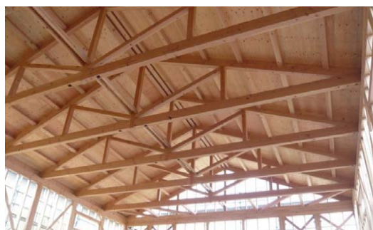
流通製材と住宅用プレカットによる 12m 間 山形トラス
